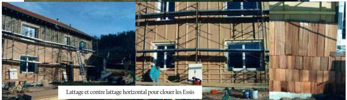
Façade isolée avec des produit naturels ISOROOF 20mm et PAVATHERM de 40mm, recouverte de Bardages (essis) fendus en extérieur et sciés en dessous le Bois est du RED Cédar (Cèdre rouge) importé du Canada réputé « imputrescible ».
